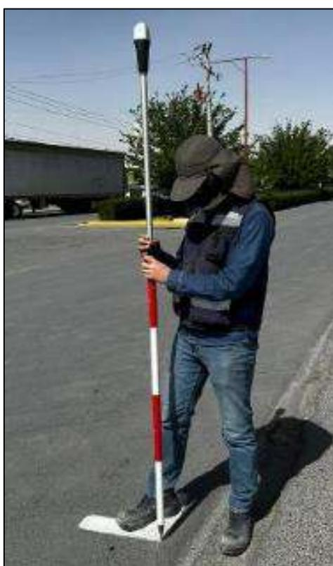
*Figura 23. Punto de control levantado con GPS RTK para vuelo de dron.*
