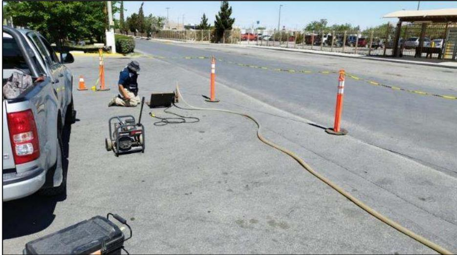
Figura 21. Trabajos de inspección en los registros o cajas de válvulas.
