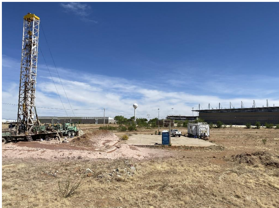
Fotografía 1. _ Sitio de trabajos de perforación
