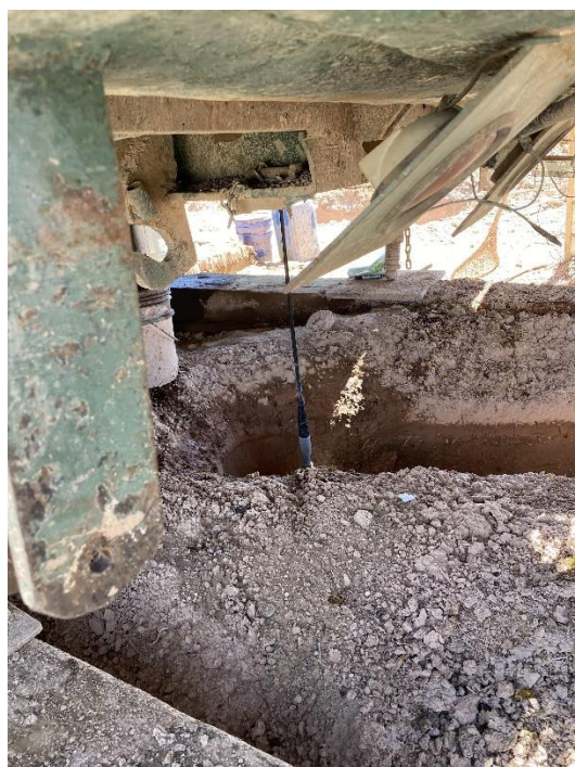
Fotografía 2. _ Colocación de la sonda de registros
